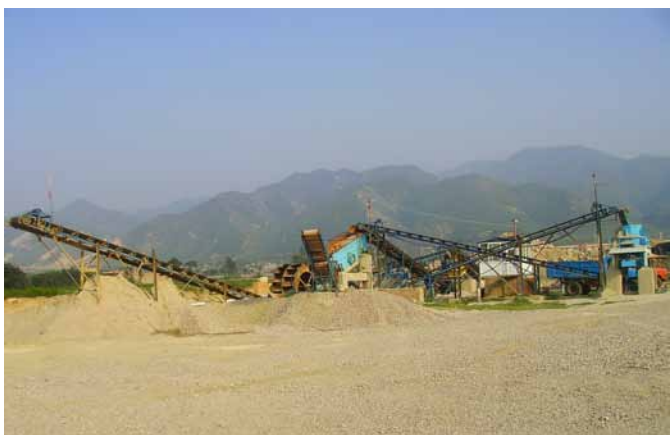
浙江湖州时产40方机制建筑砂生产线
